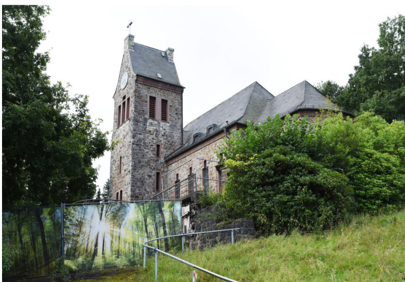
Der Schandfleck vor der Kirche soll bald der Vergangenheit angehören.
